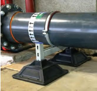
La base mousse ou caoutchouc limite l'abrasion et favorise la protection de la membrane du toit. GAC et traité anti-UV.
