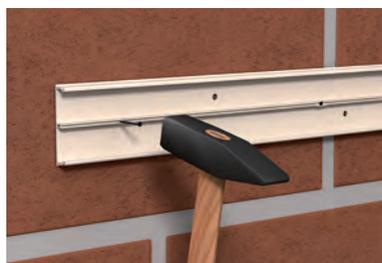
Les goulottes peuvent être fixées à l'aide de pointes ou de vis au travers des perforations prévues à cet effet
